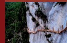
Pasarela anclada en roca en el Camino Natural
